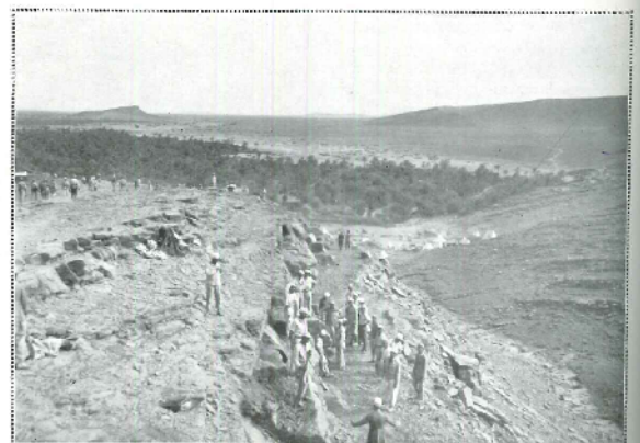
Les travaux de la piste de la 3 e compagnie montée et le ras Hamda.
