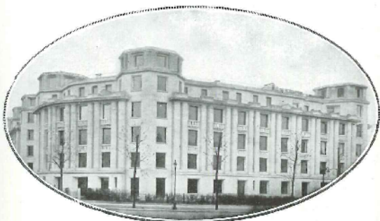
L'immeuble récemment construit, place de la Porte-de-la-Muette. (Jean Walser, archic.)
