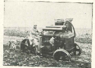
Gazogène BACO-Bois sur Fordson.
